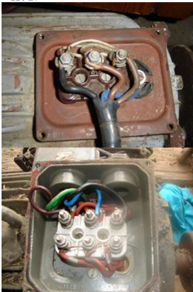
Способы подключения электродвигателей
